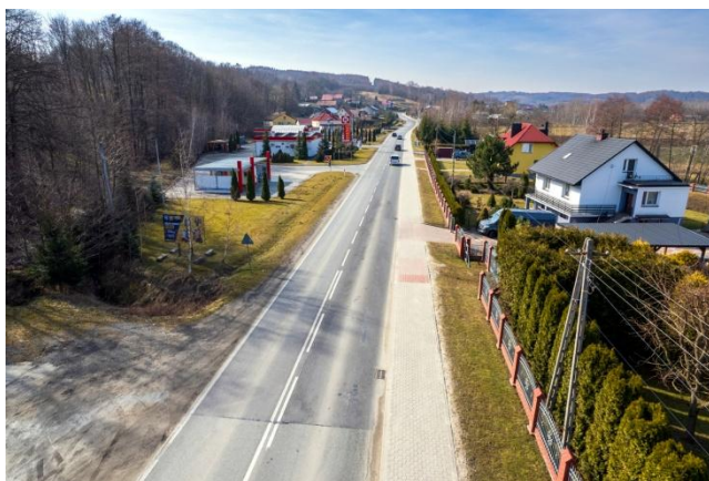
Remont chodnika przy drodze wojewódzkiej 986 na osiedlu Chechły
